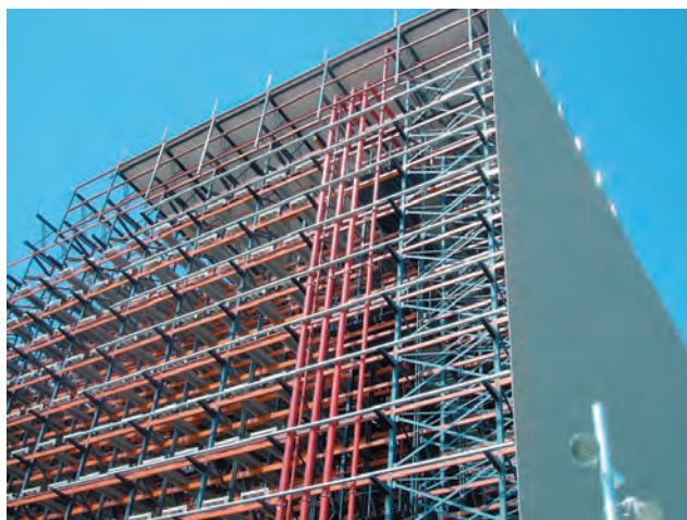
图8 货架既可建造在既有的建筑物中，也可本身形成一个建筑
